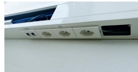
Im Brüstungskanal aus Aluminium wurden an der Unterseite FLF-Ausschnitte ausgefräst
