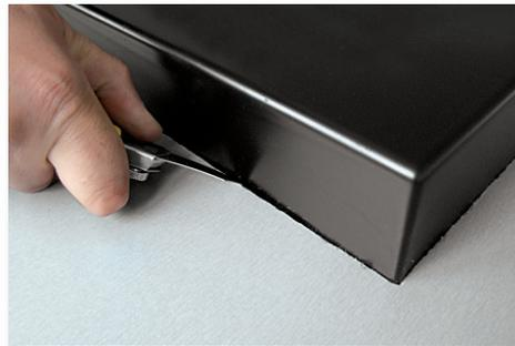
Nach dem Einbringen des Unterlagsboden resp. Fertigboden kann mit dem Teppichmesser bündig zum Boden der Deckel der Einbau-Box rundum abgeschnitten werden. Der darin liegende Sagex-Klotz kann entfernt werden.
