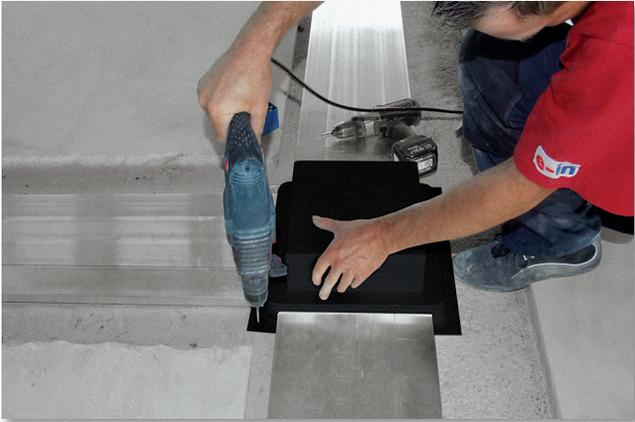
Die Einbau-Boxen werden auf die Linien sowie die Kreuzungspunkte ausgerichtet und befestigt. Danach lassen sich die benötigten Kanallängen ermitteln.
