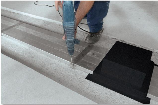
Die Kanäle werden mit Hilfe der Befestigungsbriden auf den Untergrund befestigt.
